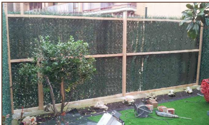
**1. Anclaje y nivelado.** Crear la estructura del área del cerramiento atornillando los rastreles entre sí y anclándolo a soportes fijos.
