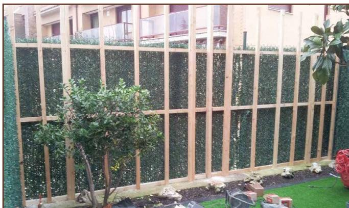
**2. Fijar los rastreles al suelo y atornillarlos con los horizontales, separados 30 o 35 cm aproximadamente.** Para suelos donde se pueda taladrar, taladrar el rastrel y el hormigón y colocar un taco de impacto.
