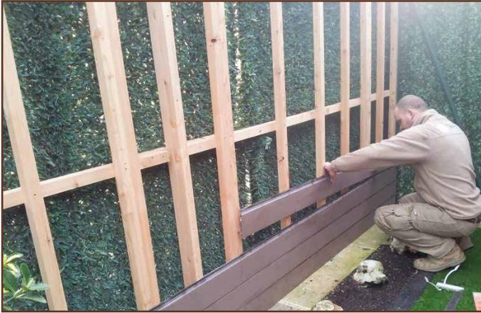
3. Una vez rastrelada el área completa y asegurándonos de que está bien anclada, **colocaremos las lamas empezando por abajo. Las anclaremos** utilizando las grapas en la ranura lateral de la tarima. Continuaremos el proceso hasta llegar a la altura deseada.
